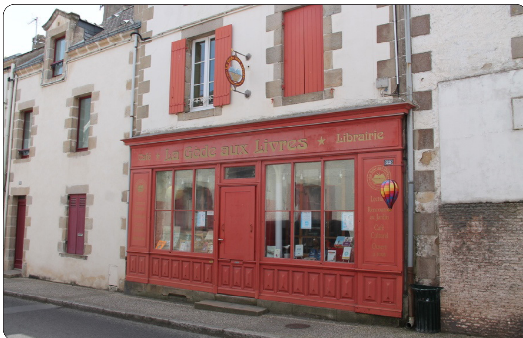
Enseignes sur façade, à plat et perpendiculaires
