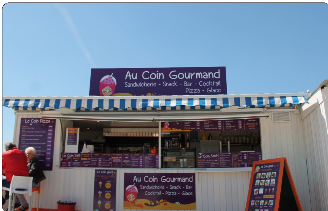
Enseigne en toiture, illégale car elle n'est pas réalisée en lettres découpées
