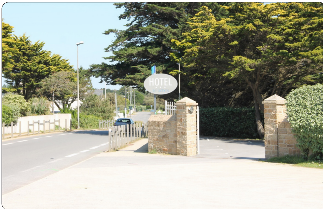
Enseigne illégale scellée au sol
