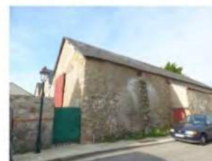
salorge visible rue de Kerdour
