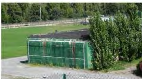
Blockhaus du complexe sportif de la Bonne Eau
