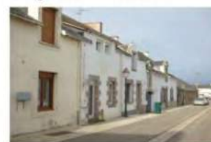
maison de bourg de type paludier rue de Kerdour
